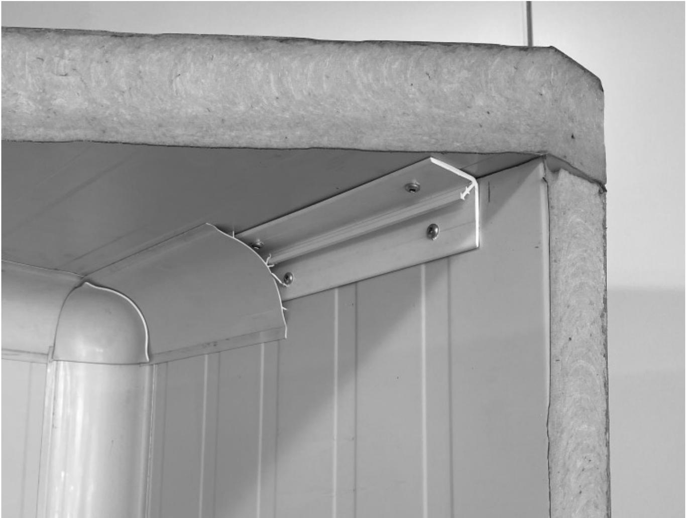
Les panneaux sandwich sont autoportants. Aucune structure distincte ne doit être fournie jusqu'à un longueur bien déterminé. Une personne peut marcher dessus.
